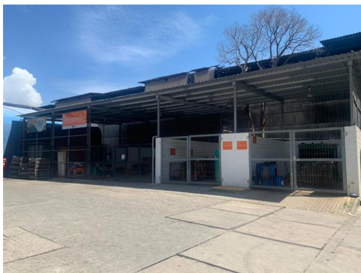
Figura 6 – Compactadora para resíduo orgânico localizada na Central de Resíduos
