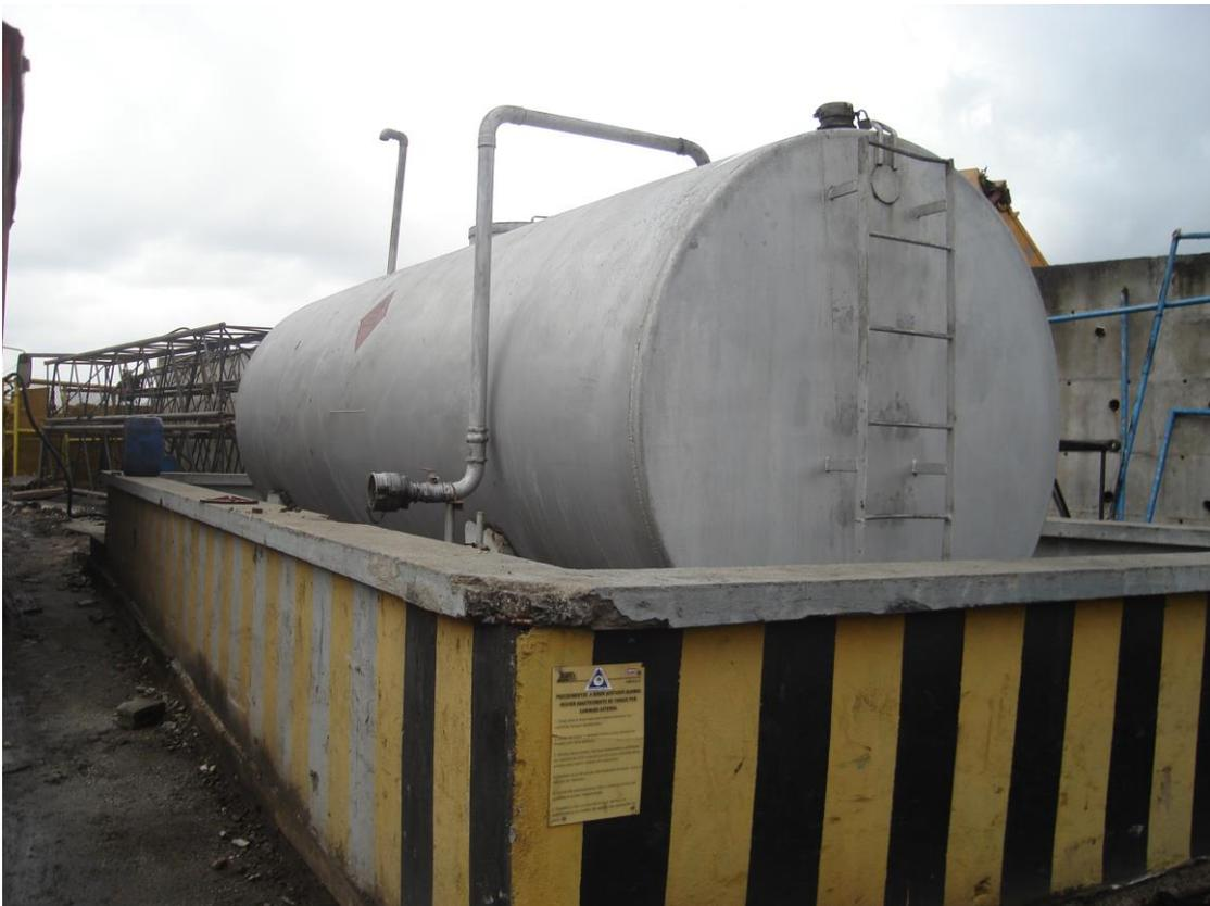
Foto 06 – Tanque de óleo diesel.
