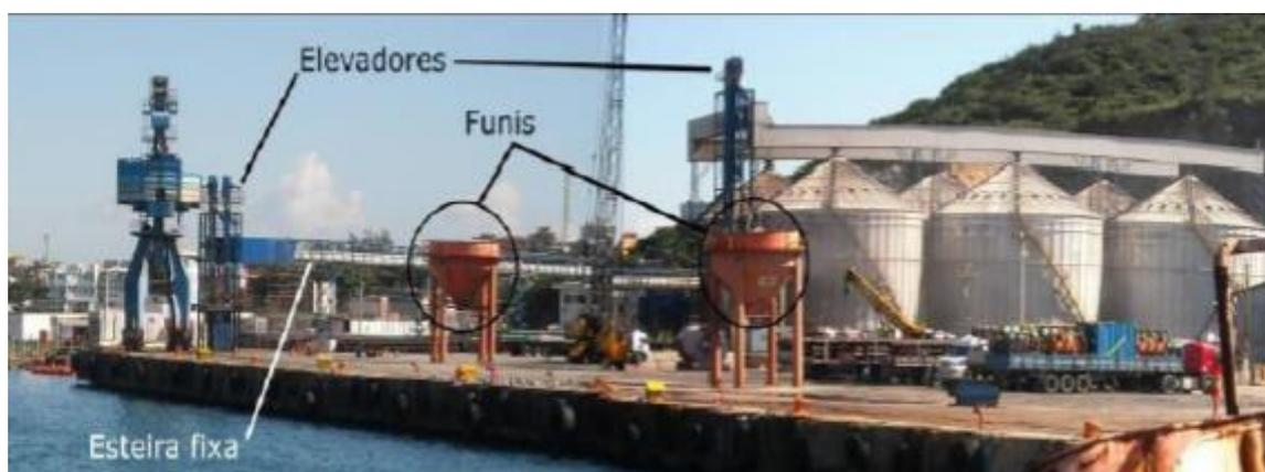
**Figura 40 - Sistema de Descarregamento e Armazenagem de Malte – Porto do Forno**
