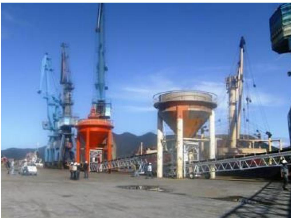
Figura 49 – Sistema de Descarregamento e Armazenagem de Malte – Porto do Forno
