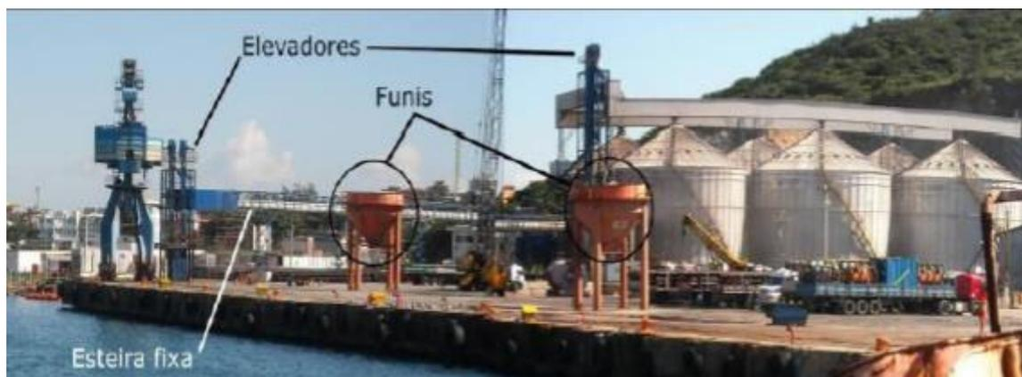
Figura 47 – Sistema de Descarregamento e Armazenagem de Malte – Porto do Forno
