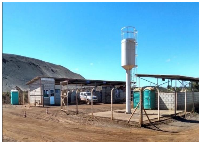
FIGURA 11 – Praças de Resíduos e área de armazenamento de resíduos
