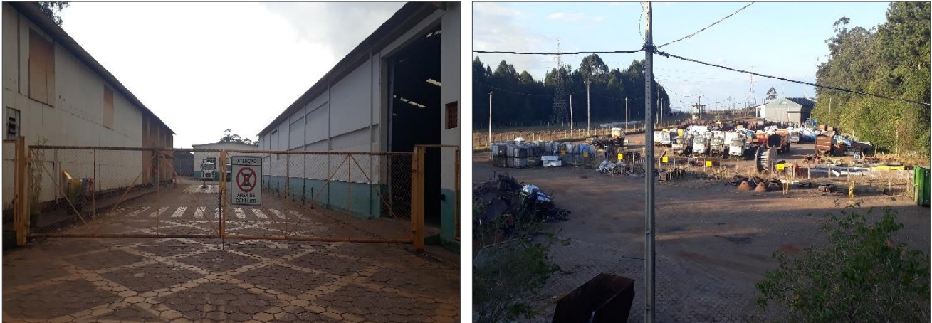
FIGURA 10 – Praças de Resíduos e tenda de armazenamento de resíduos
