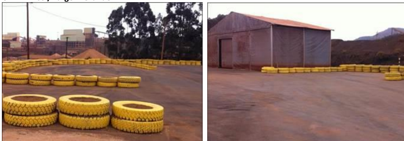
FIGURA 3 – Praças de Resíduos e tenda de armazenamento de resíduos
