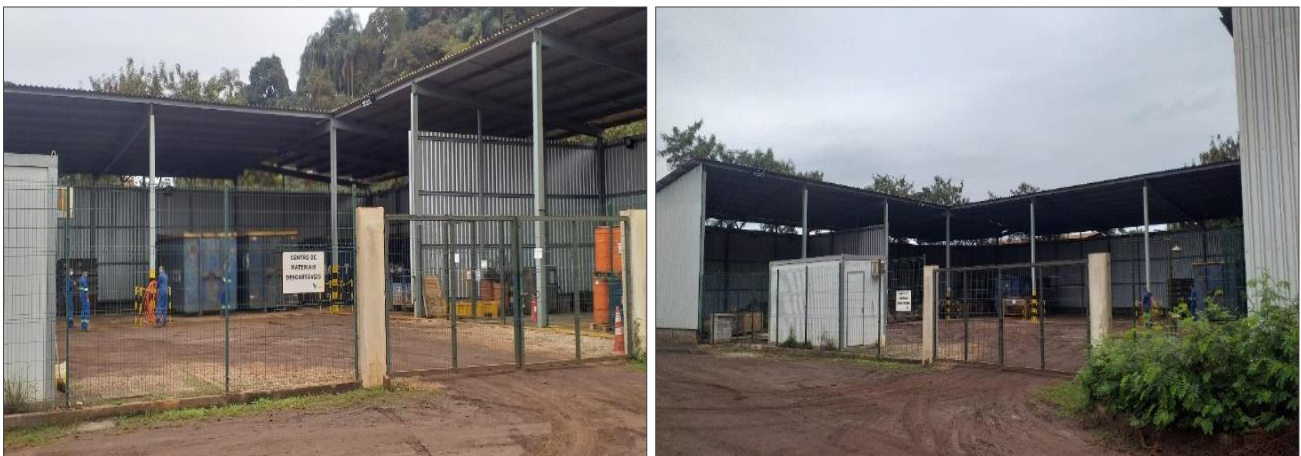
FIGURA 12 – Praças de Resíduos e área de armazenamento de resíduos
