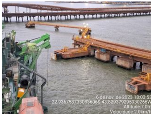
Dragagem de manutenção da Bacia de evolução do Porto de Itaguaí e do berço 401 pela Companhia Baía de Sepetiba - CPBS.
