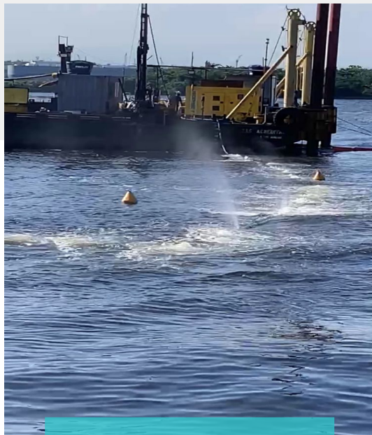
Derrocagem realizada pela ICONIC no Porto do Rio de Janeiro.
