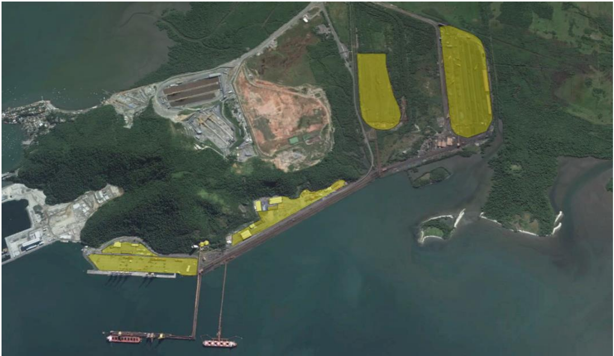
Figura 115 – Imagem aérea das áreas de armazenagem
