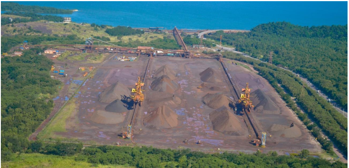
Figura 30 - Foto aérea do pátio de armazenagem CPBS
