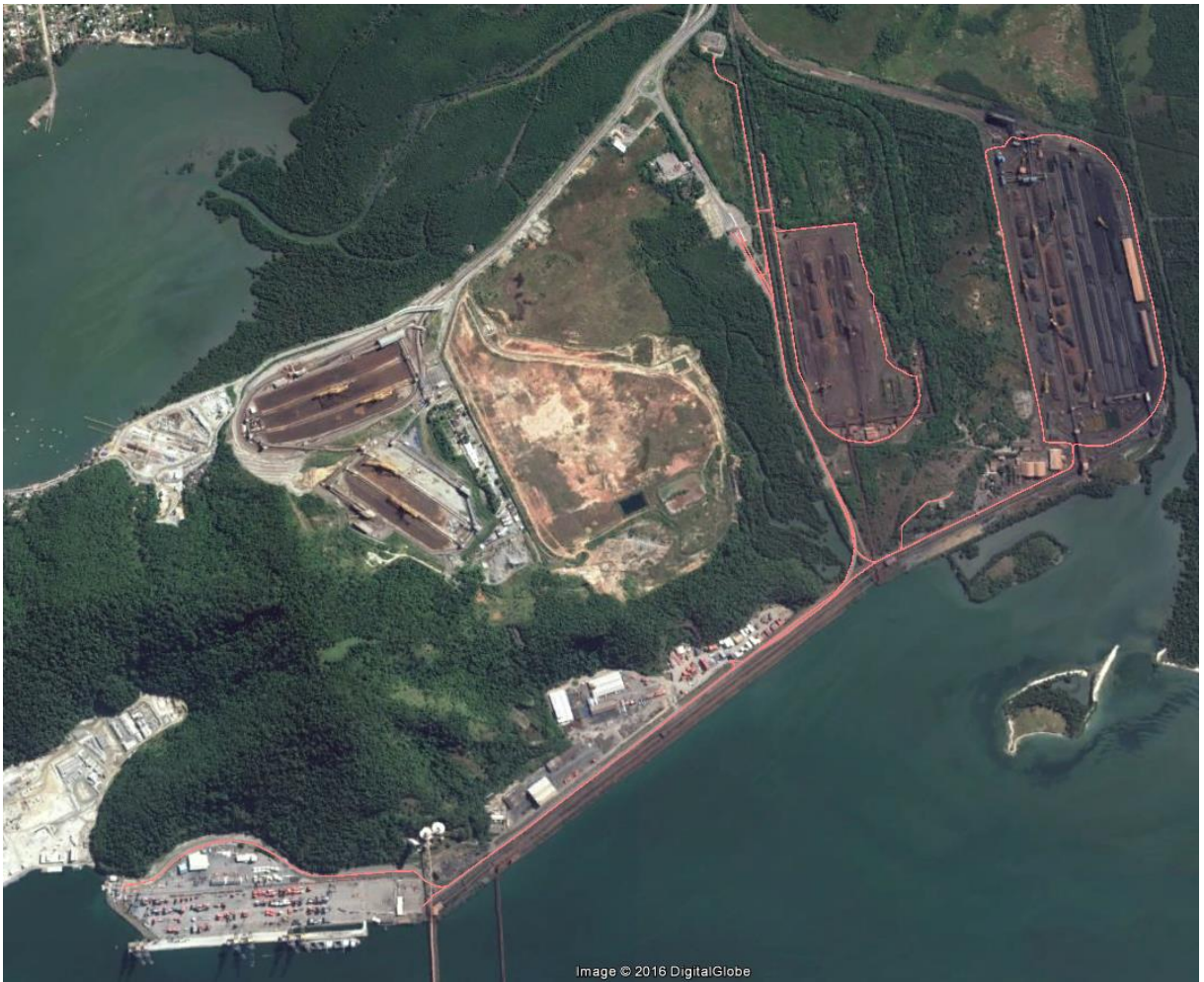
Figura 51 – Vias rodoviárias no Porto de Itaguaí
