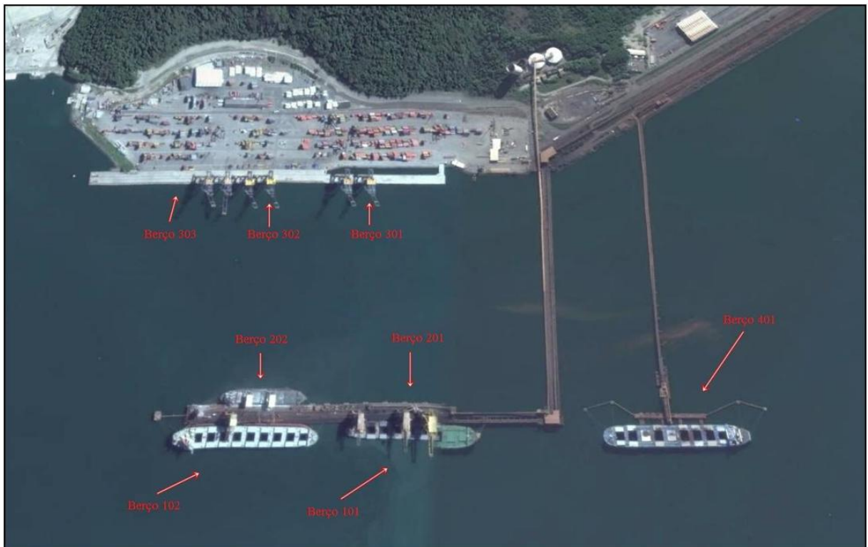
Figura 7 - Instalações de Acostagem
