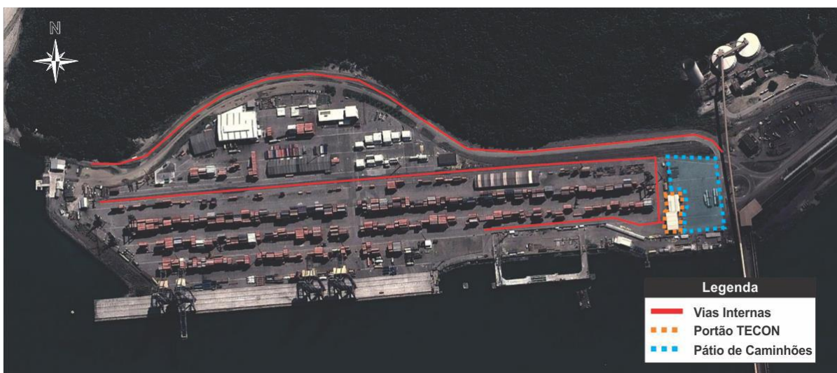
Figura 50 – Vias internas no Sepetiba Tecon
