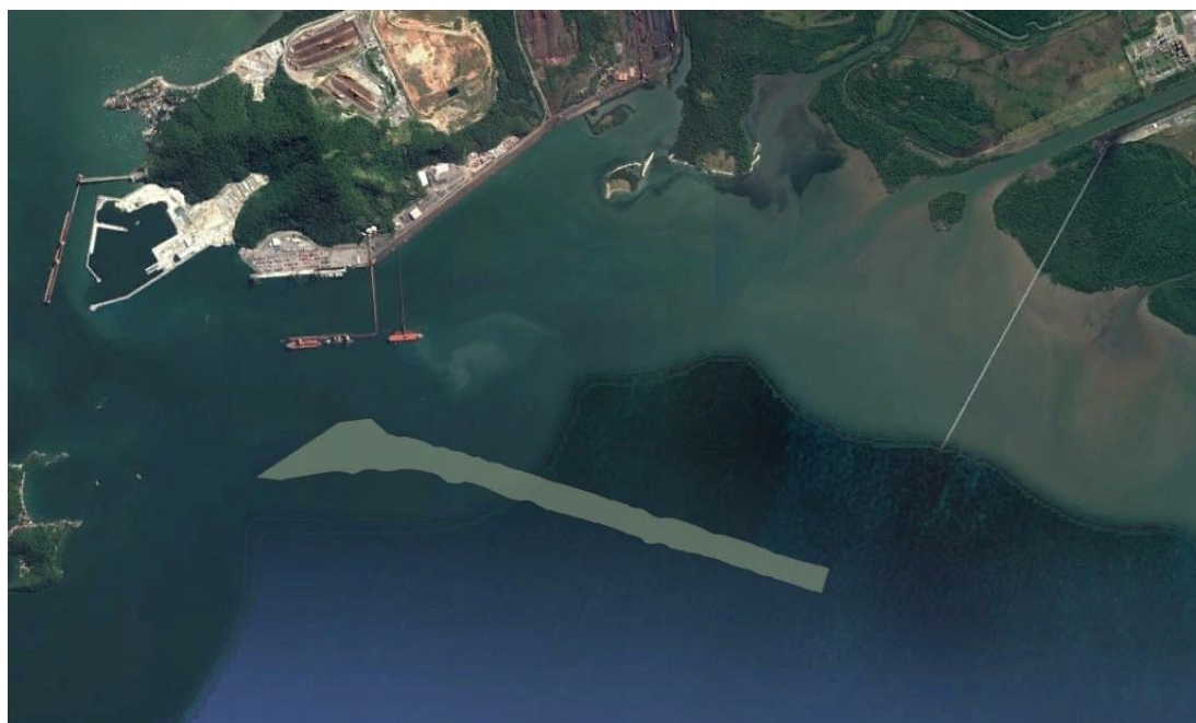
Figura 73 - Trecho do Canal TKCSA
