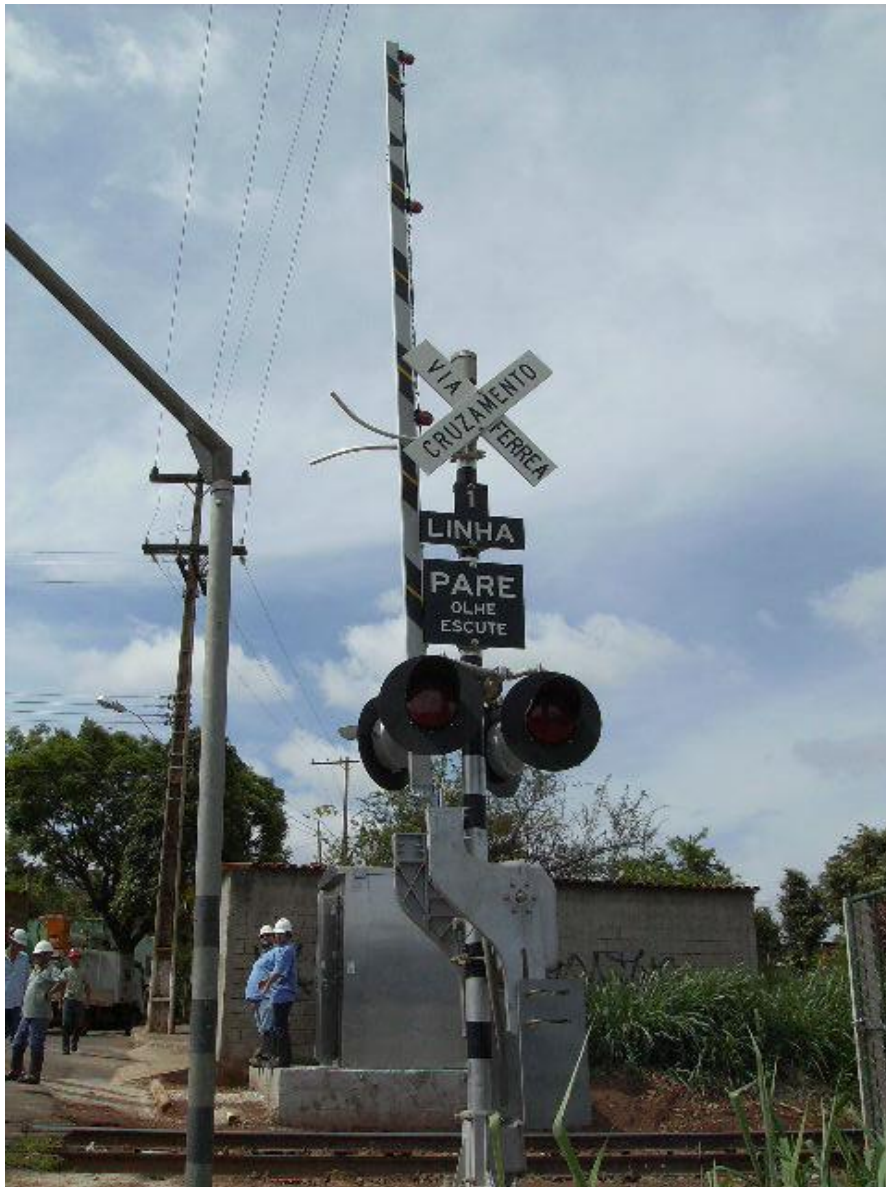
Figura 68 – Sinalização de passagem de nível
