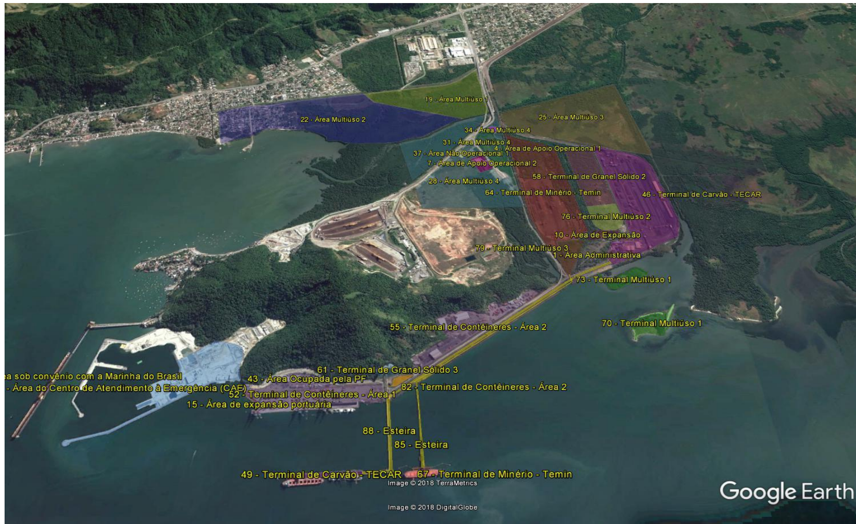
Figura 109 – Imagem aérea do zoneamento atual do Porto de Itaguaí
