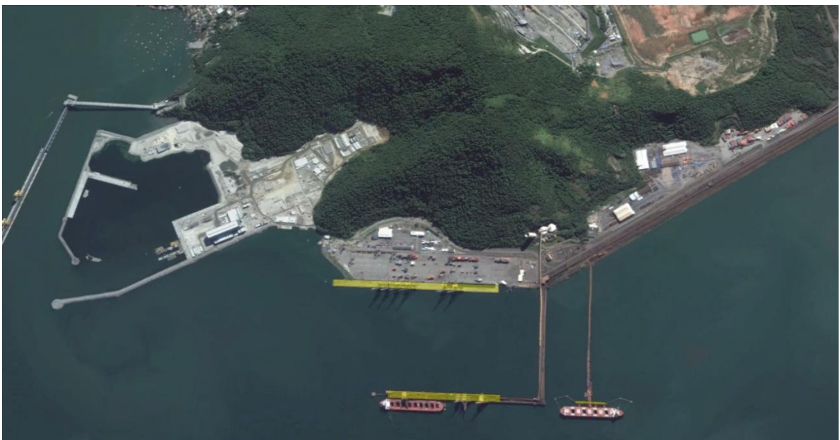
Figura 116 – Imagem aérea das instalações de acostagem
