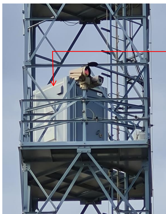
Foto 11: Cabine de Instalação da RDU do Radar montado na plataforma de serviço PS10.
