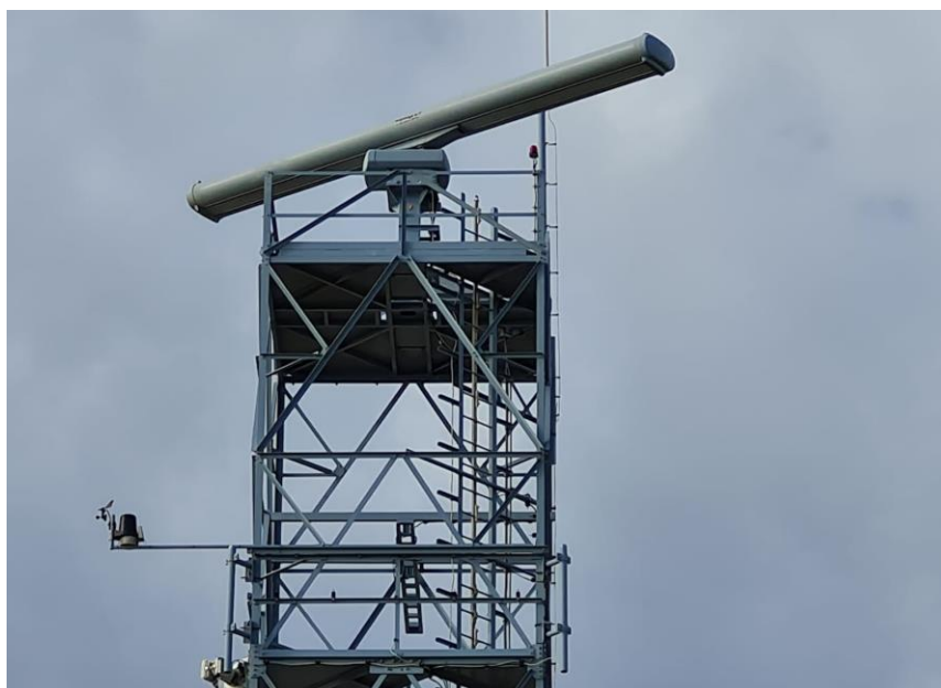
Foto 10: Posicionamento da antena do radar no topo da torre.
