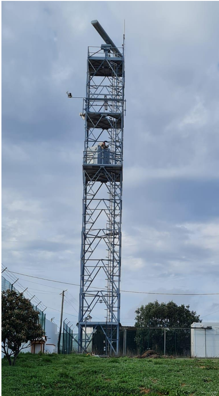
Foto 09 – Torre de 25 metros.
