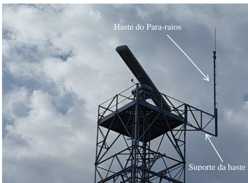
Foto 08: Vista do sistema de fixação do para-raios
