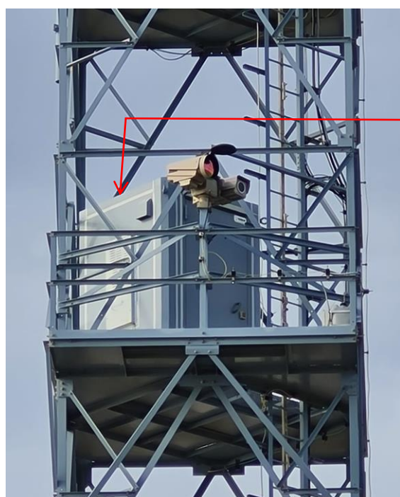
Foto 11: Cabine de Instalação da RDU do Radar montado na plataforma de serviço PS05
