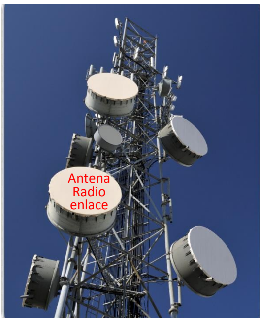
Foto 05 e 06: Antenas de rádio enlace de micro-ondas
