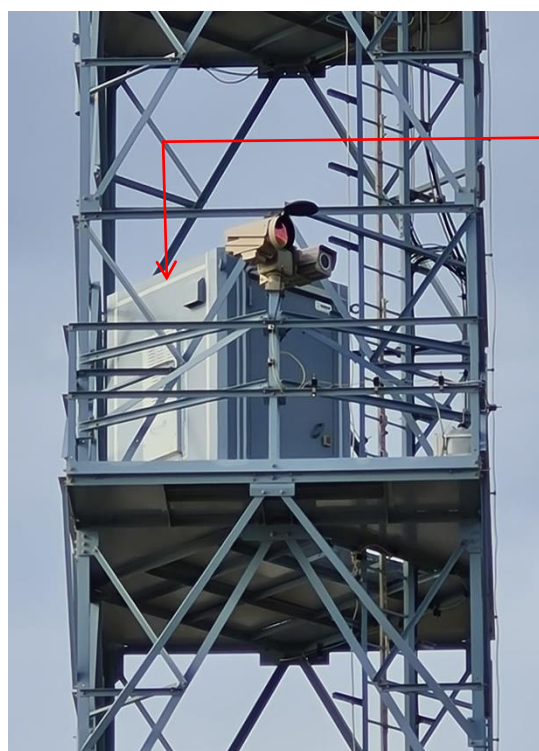
Foto 13: Cabine de Instalação da RDU do Radar montado na plataforma de serviço PS10.
