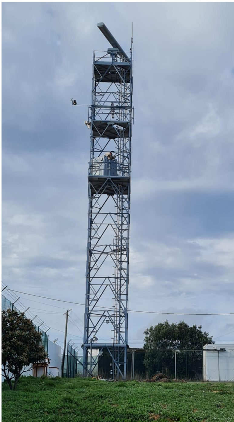
Foto 11 – Torre de 25 metros.
