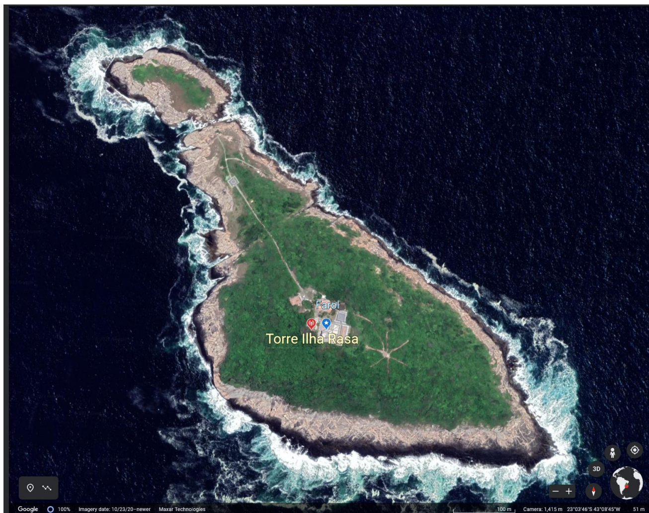
Foto 02: – Localização Torre Ilha Rasa – Vista Geral
