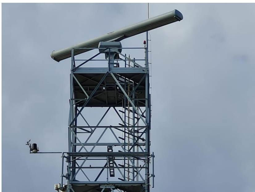
Foto 12: Posicionamento da antena do radar na Plataforma PFAR no topo da torre.
