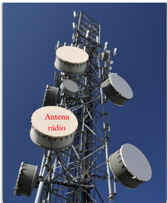
Foto 08 e 09: Antenas de rádio enlace de micro-ondas
