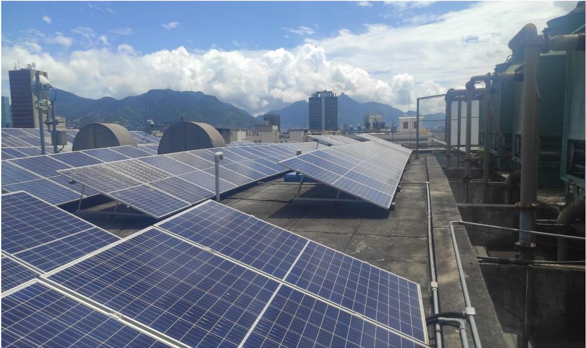
**Figura 3.** Painéis fotovoltaicos existentes na cobertura do EdBL.
