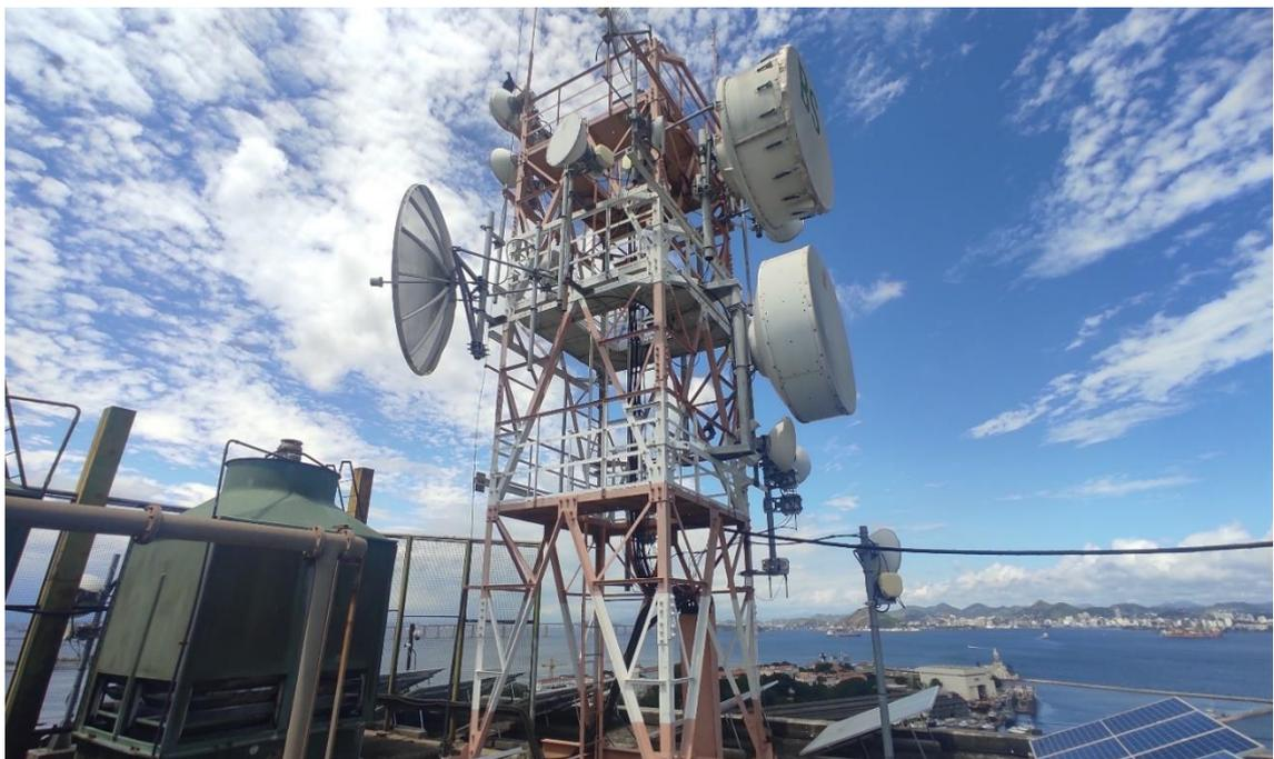
**Figura 6.** Estrutura da torre autoportante metálica existente na cobertura do EdBL.
