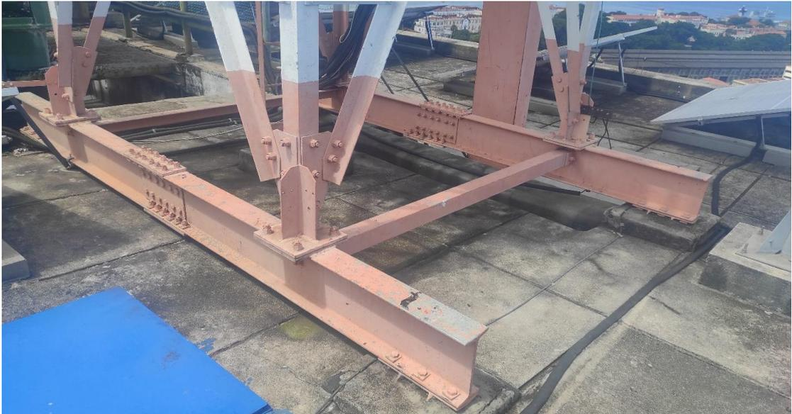
**Figura 7.** Infraestrutura da torre autoportante existente na cobertura do EdBL.
