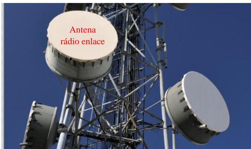
Foto 4 – Antenas de rádio enlace em micro-ondas
