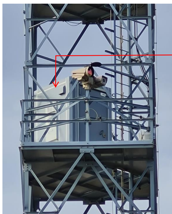
Foto 11: Cabine de Instalação da RDU do Radar montado na plataforma de serviço PS10
