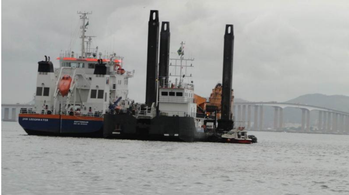
Figura 5- Draga do tipo Back Hoe com batelão a contrabordo.
