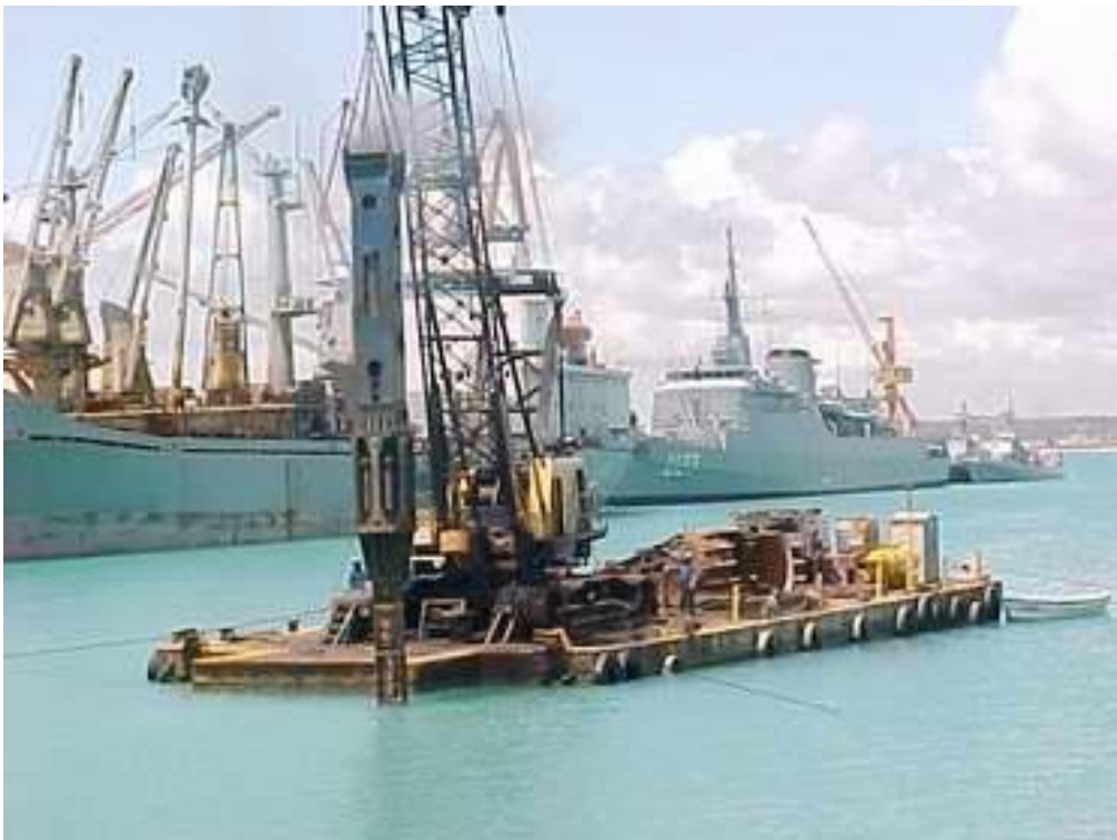
Figura 4: Derrocamento a frio com derrocadeira.
