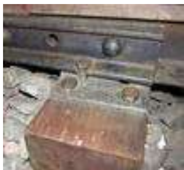
Dormente de madeira com placa de apoio e prego de linha (fixação).
