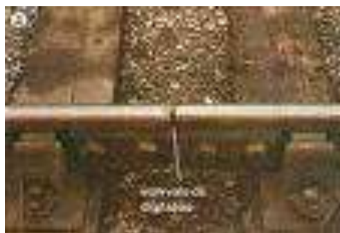
Dormente de madeira com placa de apoio e prego de linha (fixação).
